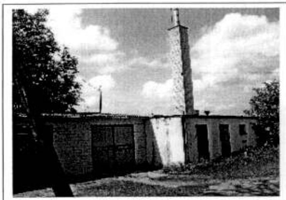
Kotłownia olejowa Stanisławów
