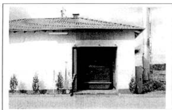
Kotłownia o mocy 750kW
