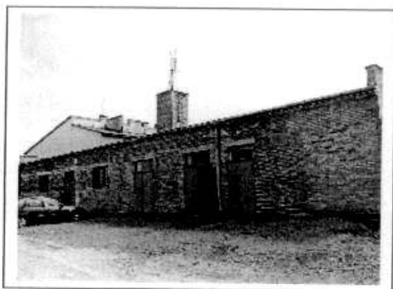
Kotłownia olejowa w Pustelniku.
