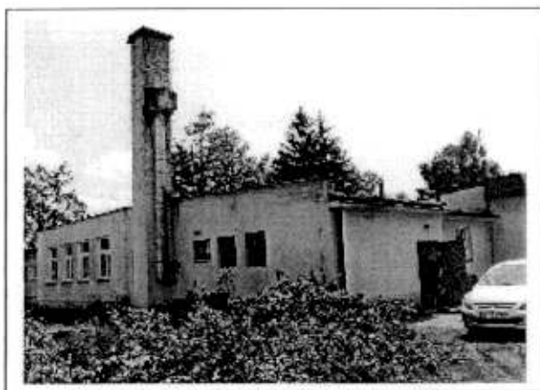
Kotłownia węglowa w Ładzyniu
